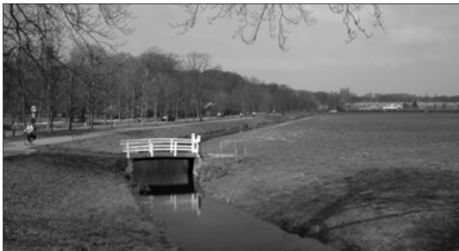
De wetgever heeft in 1927 de grens tussen Haarlem en Bloemendaal gelegd bij de sloot van het weiland van Elswout. Vanaf het Duinvlietspad had men in die tijd zicht op Tuindorp. In latere jaren is het tennispark Duinvliet in de gemeente Haarlem daar (visueel) tussen gekomen. Op een klein stukje Bloemendaalse grond moest een uitrit komen voor het Haarlemse tennispark. Dat vond Bloemendaal een aantasting van de Elswoutslaen. De uitrit is er toch gekomen. Foto 2007.
