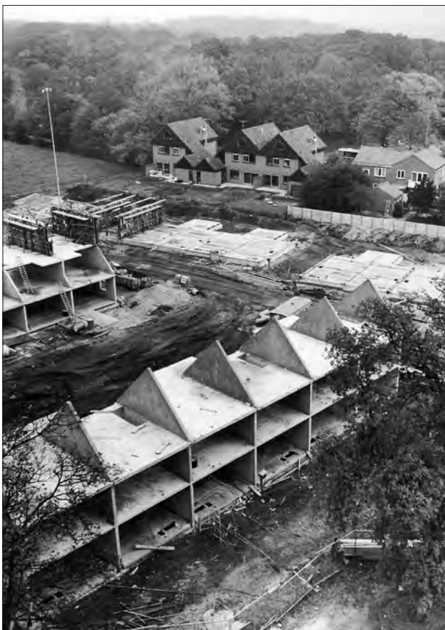
De huizen van de Godfried Bomanslaan in aanbouw in 1976.
