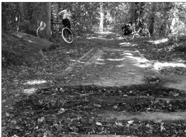
Betonnen onderbouw van een V-1 stelling. Niet in Vogelenzang, maar in Bergen (N.H.)
