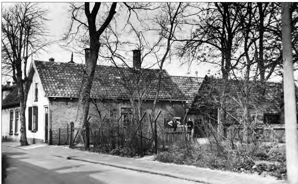
Graaf Florislaan. Werkplaats van Van Tongeren met muur van de oude rooms-katholieke begraafplaats.
