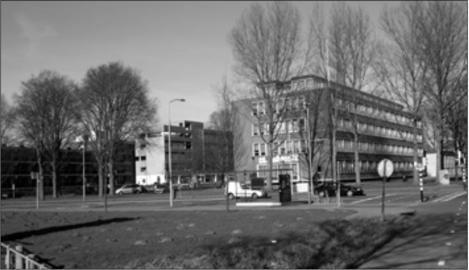
Het kruispunt van de Westelijke Randweg en de Zijlweg. Goed zichtbaar zijn de toenmalige HTS, nu verbouwd voor studentenhuysvesting, een kantoor van de provincie Noord-Holland en een aantal koopflats. Foto 2008.
