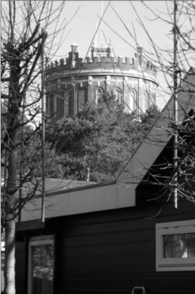
De watertoren domineert het ‘Watertoreng gebied’.
