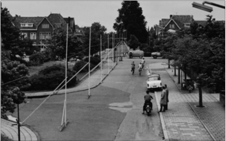
Het profiel van het viaduct van de Westelijke Randweg over de Julianalaan werd in 1959 in ware grootte opgericht. De foto toont de Willem de Zwijgerlaan gezien in de richting van de Julianalaan met het plantsoen in de middenberm dat bij de bouw van het viaduct moest verdwijnen. Foto Noord-Hollands Archief, bld. 7886.
