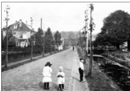
Deze foto van de Ramplaan in 1920 doet erg veel denken aan de leesplank van de lagere school met Wim, Zus en Jet. Links het nog steeds bestaande pand Bloomfield, dat in die tijd in het bezit was van de familie A.J. Neelissen. Hoe anders is het huidige verkeersbeeld van de Ramplaan. Foto archief Mandjes.
