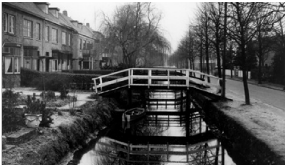
De Ramplaan was in 1927 de belangrijkste woonstraat. Kenmerkend zijn de woningen aan de oostkant met sloot en bruggetjes. De foto is van 1936. Foto archief Mandjes.
