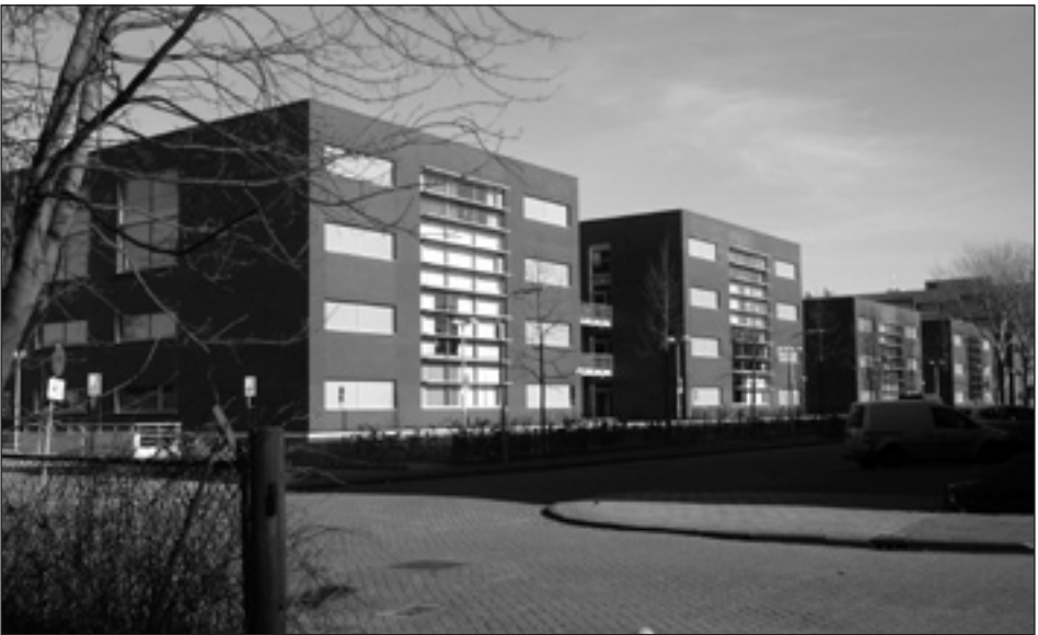
Nieuwbouw van INHOLLAND Haarlem aan de Bijdorplaan. Foto 2007.
