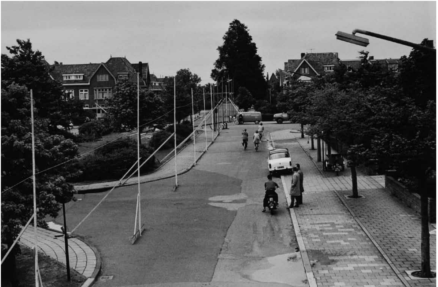
Het profiel van het toekomstige viaduct van de Westelijke Randweg vlak bij de Julianaschool op de hoek van de Willem de Zwijgerlaan en de Julianalaan in 1959.
