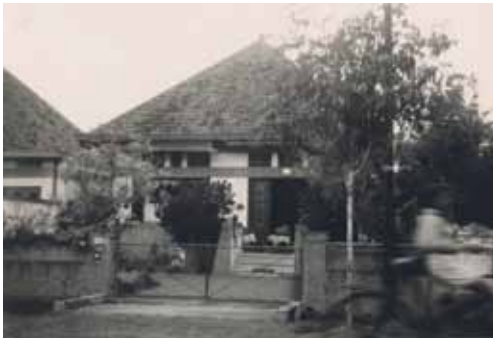
Het woonhuis van Piet en Els in de Bilitonstraat 38 in Soerabaja.
