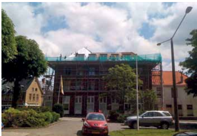
Renovatie van het pand vanaf 2004. (Foto: Arend van der Sluis)
